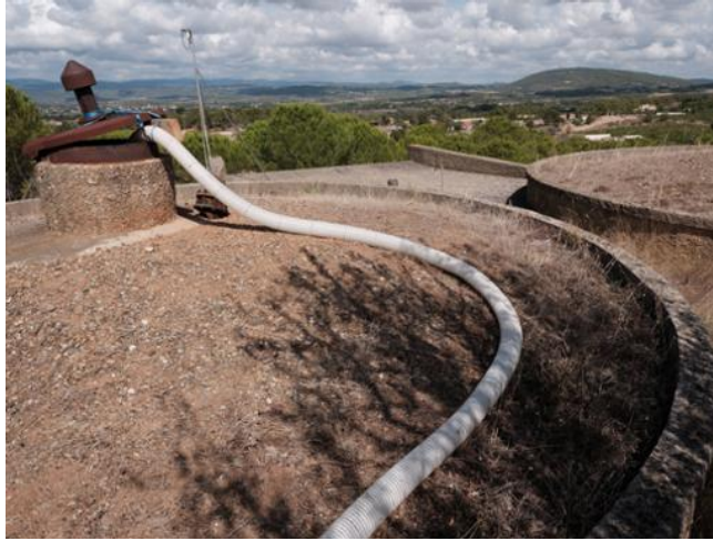
Remplissage du château d'eau du village de Tourouzelle (Aude), le 15 septembre. RÉMY GABALDA/MAXPPP
